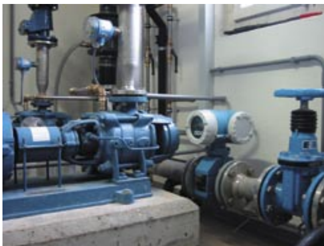
Измерение объемного расхода с помощью электромагнитного расходомера Promag 50W TI 046D/06/en*
