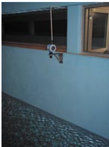
Бесконтактное измерение уровня ультразвуковым уровнемером Prosonic M FMU 40 TI 365F/00/en*
